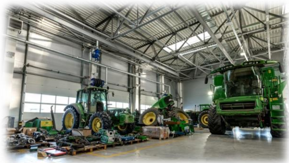
Строительство МТМ для ремонта и обслуживания автотранспорта и сельхозтехники хозяйства (с. Нижний Иртыш)
