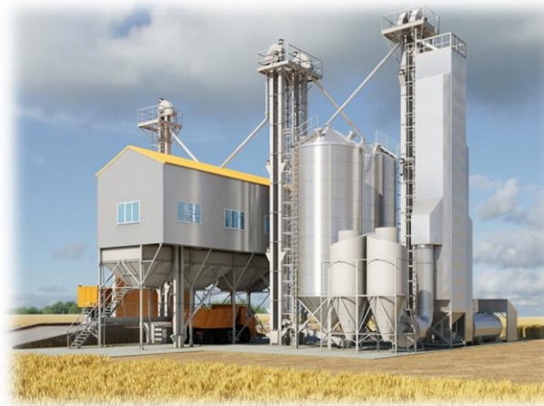
Строительство зерносушилки (д. Верблюжье)
