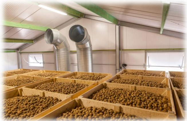
Строительство картофелехранилища (с. Увальная Бития)
